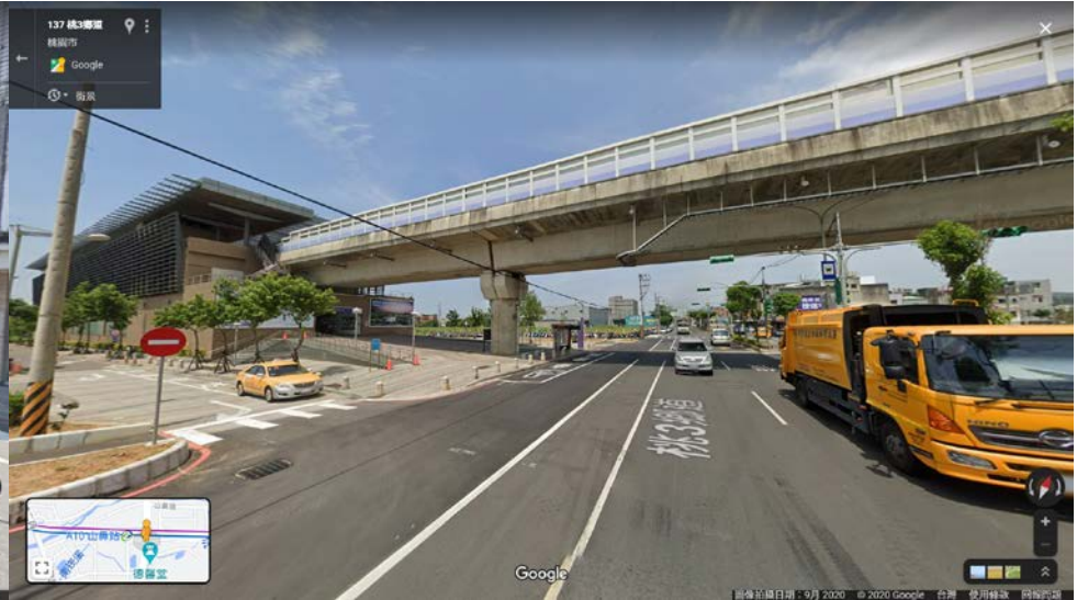
第二站：機捷山鼻站
